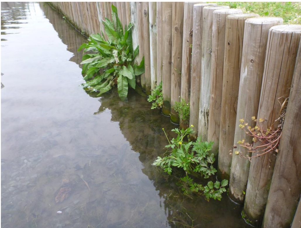
写真2 生き物の生息に配慮して改修した区間（I3）に侵入してきた植物
