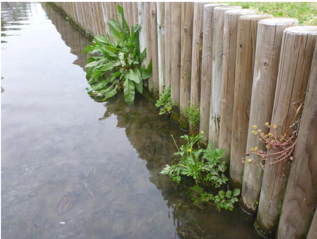
写真2 生き物の生息に配慮して改修した区間（I3）に侵入してきた植物
